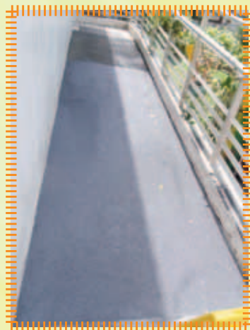
重鋪B214對出斜坡位置之防滑鋼沙
