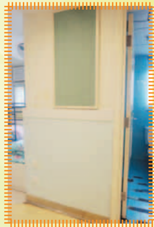
更換房間內已爛掉的防火板
