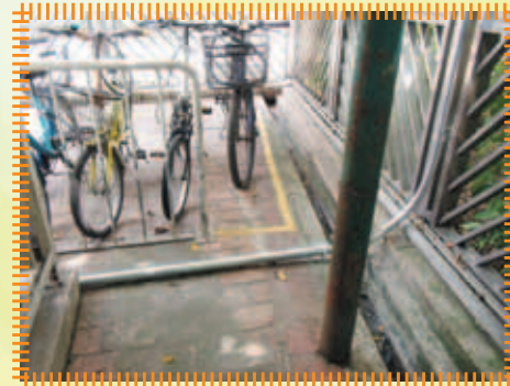
重整C座連接保安室之防水地線，確保中心外圍電力供應穩定
