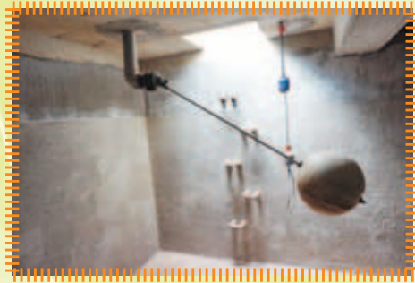
六樓天台消防水缸防漏工程
